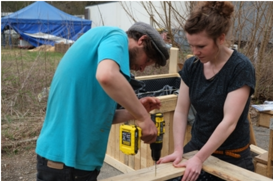
Bau von Hochbeeten
